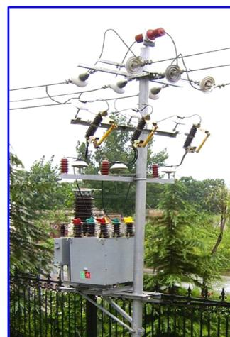
未配置电抗器，电容器投入时涌流冲击电网并降低电容器的使用寿命。
