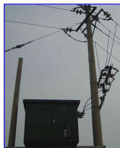
特别是，体积大，质量重，需双杆安装，安装时需要动用大型吊装设备，不适于野外运输安装。
